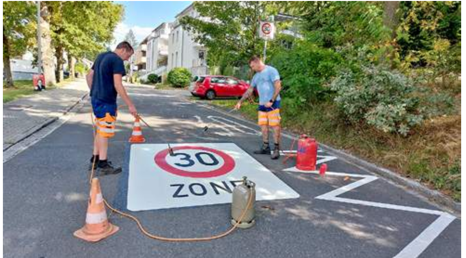
Die Mitarbeiter des Bauhofs beim Erneuern der Tempo-30-Fahrbahnmarkierung in der Waldstraße, im Bereich der Einmündung in die Birkenallee. Dazu wurden die Markierungen zunächst auf den Untergrund aufgetragen und im Anschluss mit einem Gasbrenner eingeschmolzen, um ein festes Anhaften am Untergrund zu ermöglichen. Foto: Monika Eckert
