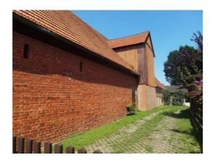
Ein vermutlich älterer Scheunenkern könnte von 1731 stammen. Die heute prägende Ziegelfassade wird auf Anfang des 20. Jh. vermutet. Dass die Scheune Richtung Straße verlängert wurde belegen die alten Pläne und ein liegender Stuhl im DG, der in etwa der Linie des früheren Giebels in den Lagepläne entspricht.
