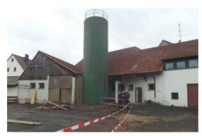
Die Konstruktionen, die sich aus den mehrfachen Umbauten ergeben haben, können z.T. als statisch gewagt betrachtet werden und sind keinesfalls für Umbauten geeignet.
