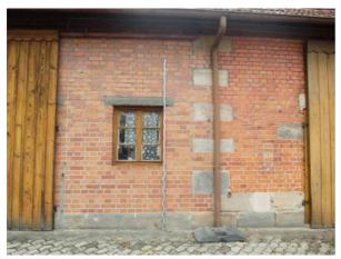
In der Scheune findet man zahlreiche Spuren der Wiederverwendung von Bauelementen. Viele Hölzer der Dachkonstruktion zeigen, dass sie ursprünglich an anderer Stelle, vielleicht sogar an anderen Gebäuden verbaut waren. Die Ziegelsichtfassade hat einen Sockel und Zierelemente aus Sandstein, die evtl. noch vom Vorgängerbau stammen. Dadurch harmoniert das Gebäude schön mit dem Sandstein-Wohnhaus.
